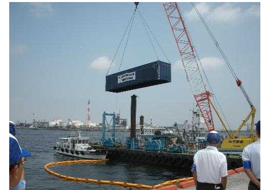
図 訓練でのコンテナ引き揚げ状況
