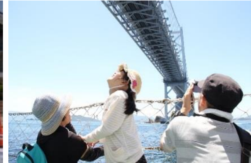
瀬戸大橋を見上げる
