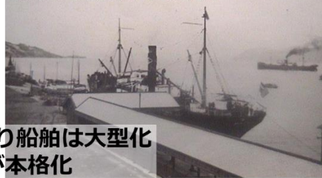
昭和16年頃：西岸壁の完成
