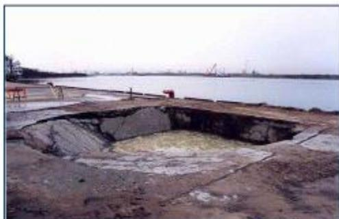
裏込め土の吸出しによるエプロンの陥没
