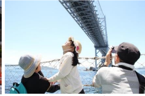
瀬戸大橋を見上げる
