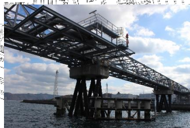
桁下から水面まで約12m
