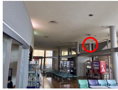
高松港旅客ターミナル2Fに常設されたWi-Fi設備
