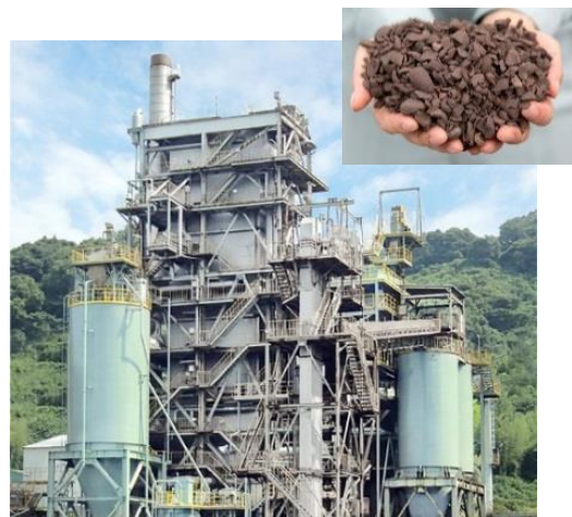
バイオマス発電所
