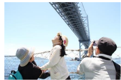
瀬戸大橋を見上げる
