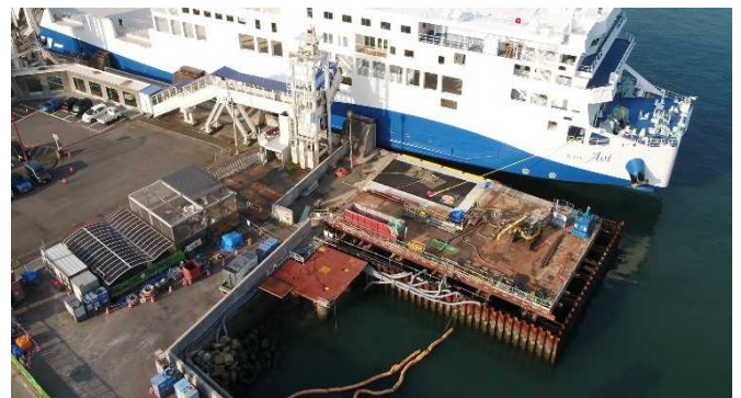
新船「あおい」着岸状況
