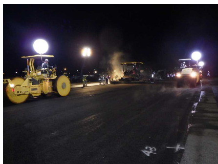
▲舗設状況 (H27工事)
