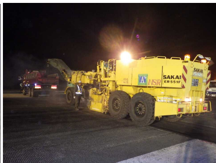
▲切削状況 (H27工事)
