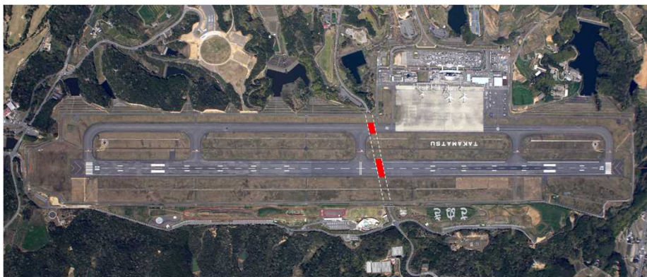
▲地下道耐震補強予定範囲
