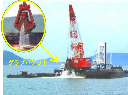
▲浚渫工事の状況
