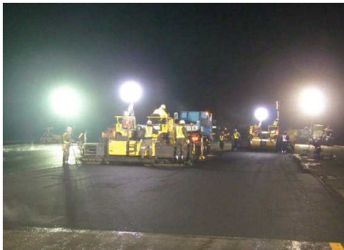
▲昨年度の誘導路改良工事の状況
