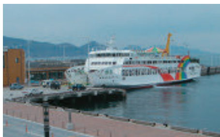
離島フェリー岸壁
