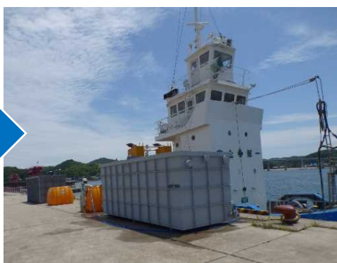
貯水・給水タンクを設置
