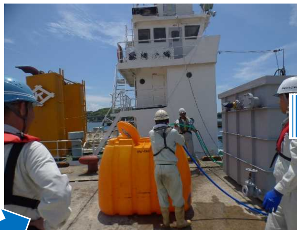
給水タンクに注水
