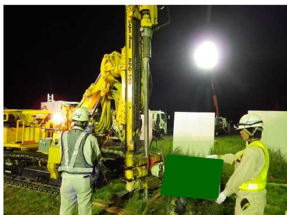
地盤改良(薬液注入)用の鉛直削孔を施工している様子(写真は他工事の事例)
