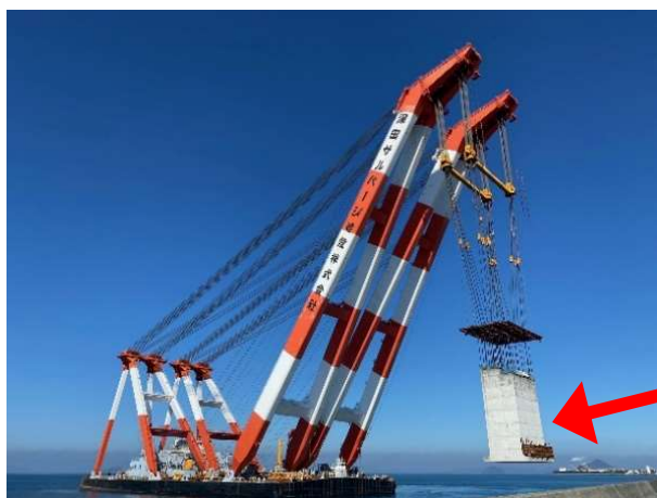
※写真は、令和6年2月17日に同現場で実施された作業の様子です。
