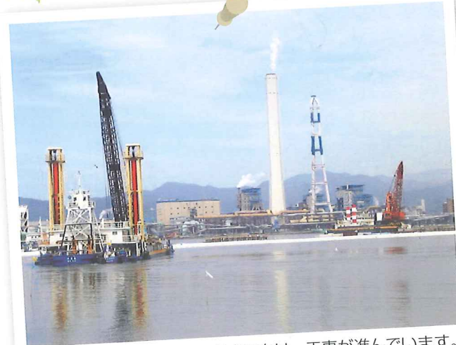
多目的国際ターミナルの完成に向け、工事が進んでいます。
