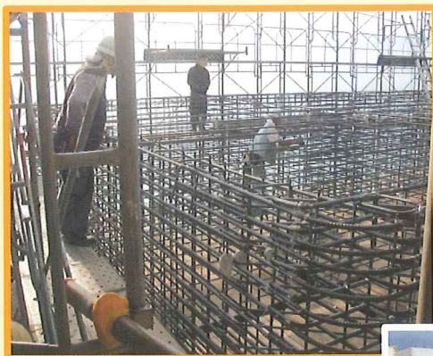
▲鉄筋の加工・組立の様子。ケーソン1函あたり約60tの鉄筋が使われています。
