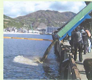
▲ダンプカーによる土砂投入
