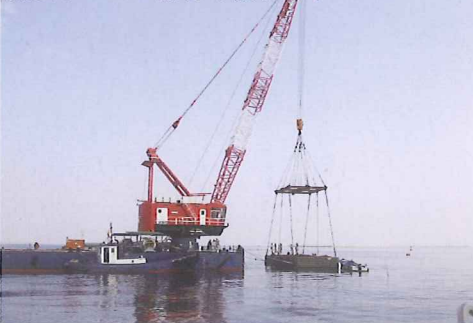
撤去ケーソン据付の様子
