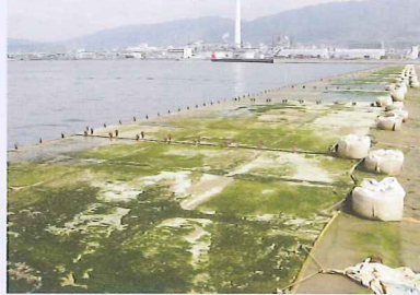
岸壁 (-14m)【H19.3撮影】
