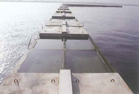
防波堤 (北) (ケーソン全函の据付完了)
