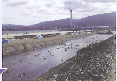
岸壁 (-14m)【H19.11撮影】
