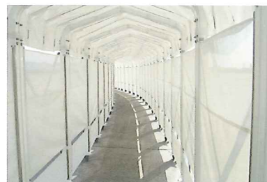
エプロンルーフの内部
