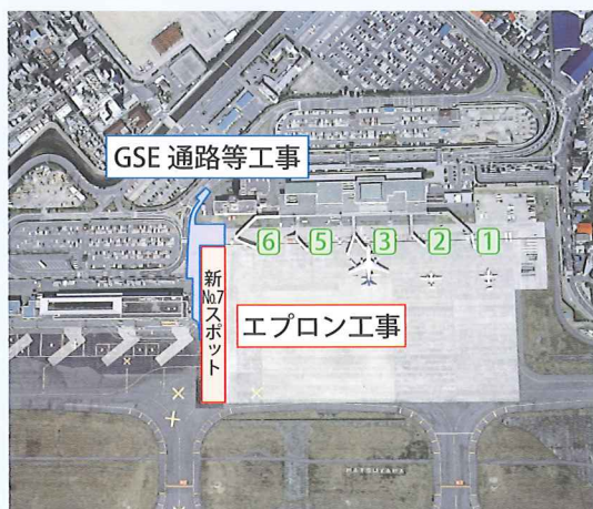
上空からの松山空港（H19.3撮影）
