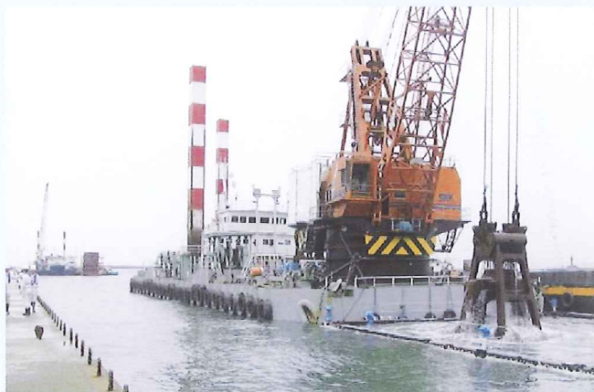
グラブ浚渫船で泊地を浚渫している様子
