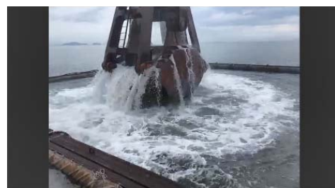
施工状況（浚渫）のライブ配信
