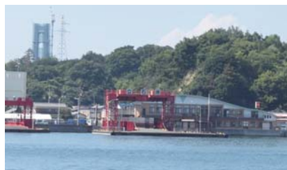
愛媛県側の代表施設、立石港務所 奥には建造中の岩城橋が見えます
