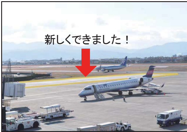
新設エプロン
