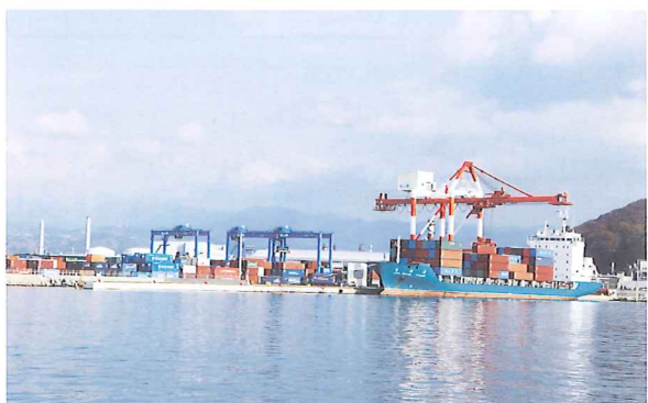
現在、暫定供用中の水深-10m岸壁で荷役が行われる様子。係船中の岸壁の先が水深-13m岸壁。
