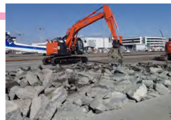
昼間：コンクリート舗装撤去
