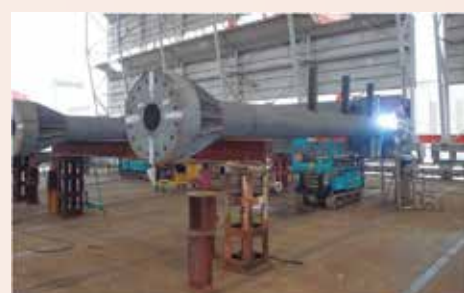
可動橋製作状況
