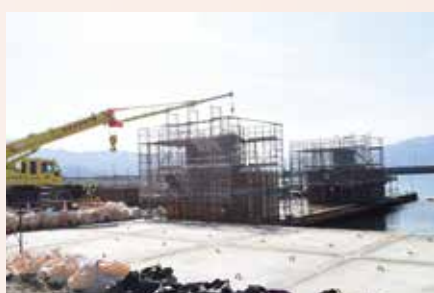
可動橋基礎工事
