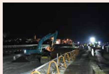
護岸の耐震補強工事
