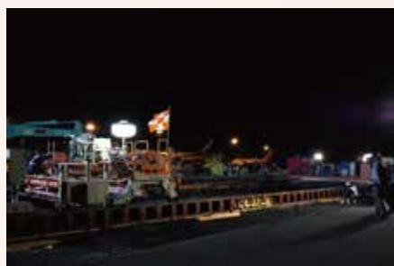
エプロン舗装工事
