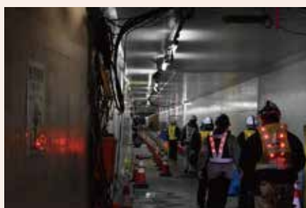
地下道の耐震補強工事
