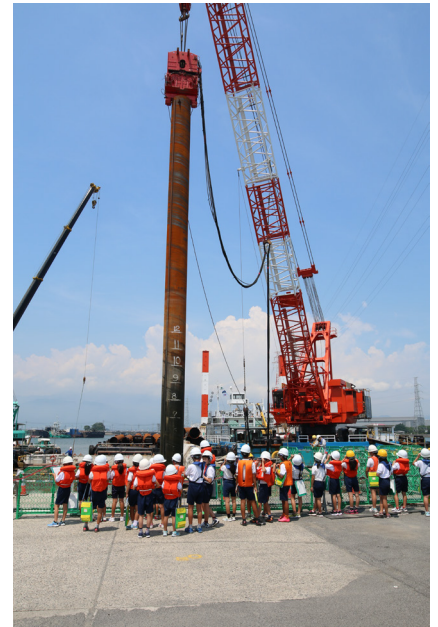
杭打作業の状況。大きな鋼管矢板が地面に入っていく様子は圧巻です！
