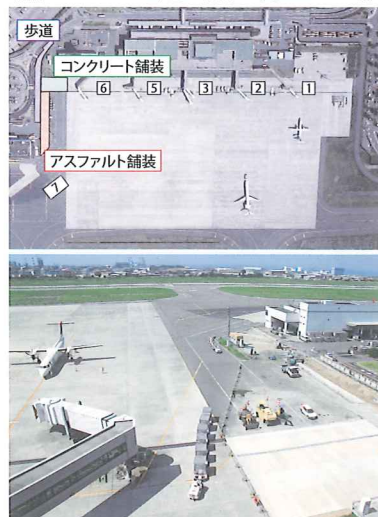
GSE通路をコンテナ貨物が運ばれて行く。 GSE通路は航空機をメンテナンスする車両や貨物を運搬する車両などの交通に利用される。
