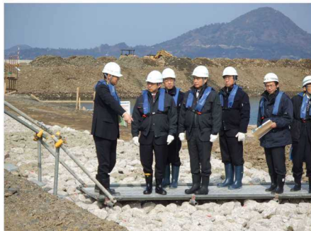
▲埋立工事現場の視察
