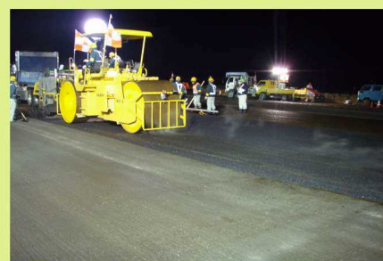
③ロードローラーで締め固めて完成です。
