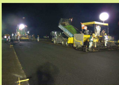
②新しいアスファルトを敷き均します。
