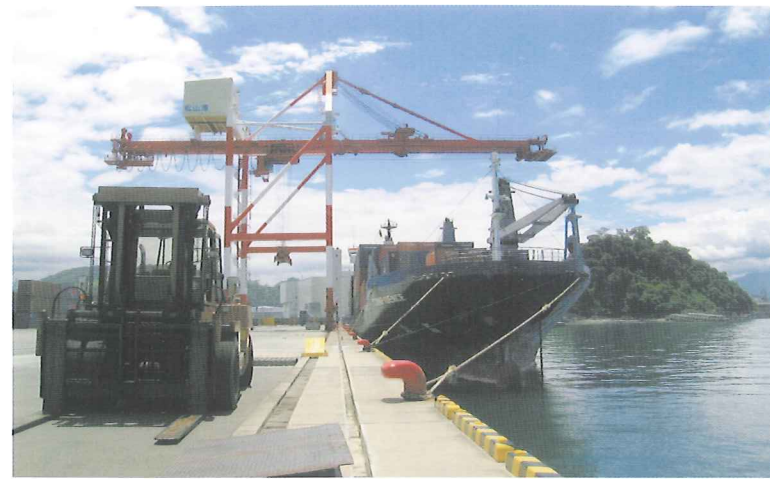
新埠頭1号岸壁は水深-10m、1バース、延長170m、載荷重量1万トクラスの船舶を対象に整備。緊急時の物資の輸送に備え、耐震性を強化。
