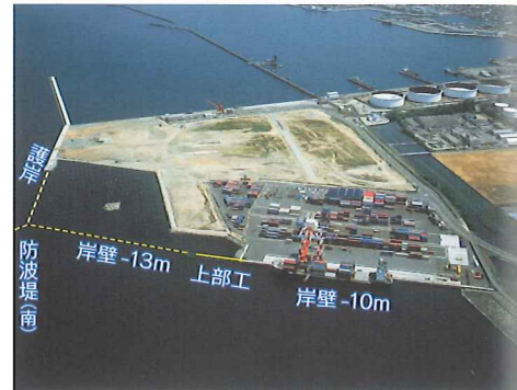
新埠頭1号岸壁は水深-10m、1バース、延長170m、載荷重量1万トクラスの船舶を対象に整備。緊急時の物資の輸送に備え、耐震性を強化。
