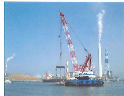
四国中央市の臨海部には基礎産業である製紙業などの工場が集積しています。三島川之江港を經由して近隣の工場をはじめ、四国縦貫・横断自動車道の延伸に伴い四国内の工場に原料等が供給され、また加工された製品が出荷されています。輸送貨物の増大により荷役待ちのための滞船が増加し、荷さばき地の不足も生じています。これらの解消ため金子地区に岸壁(1バース、水深-14m、計画延長280m、対象船舶5万ト)やその前面に泊地などを当所て整備しています。
