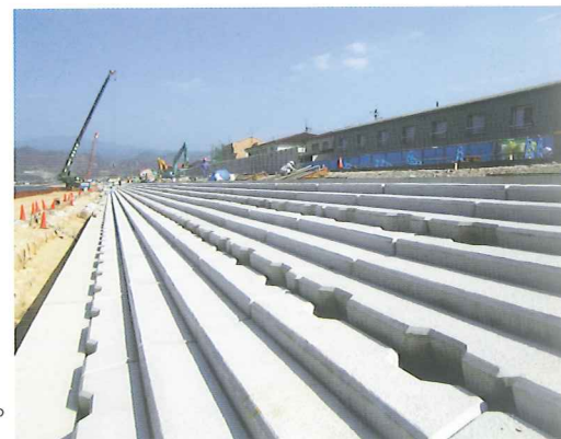
堀江浜側の堤防改良工事の様子。(権現川方向を望む)
