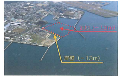
▲松山港外港地区
