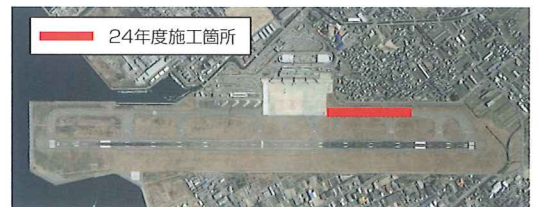
▲松山空港工事実施箇所
