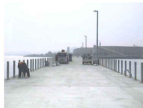
▲防護柵整備作業
