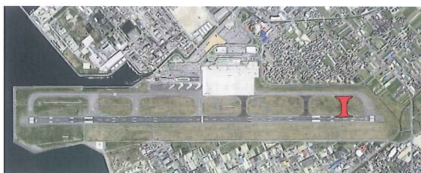
▲松山空港(赤色箇所が平成23年度施工箇所)
