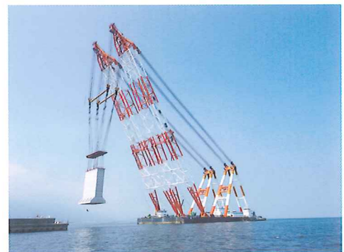
▲ケーソン据付作業
