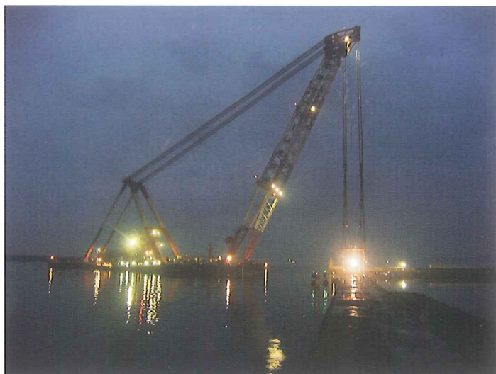
▲起重機船を使ってケーソンを据付
