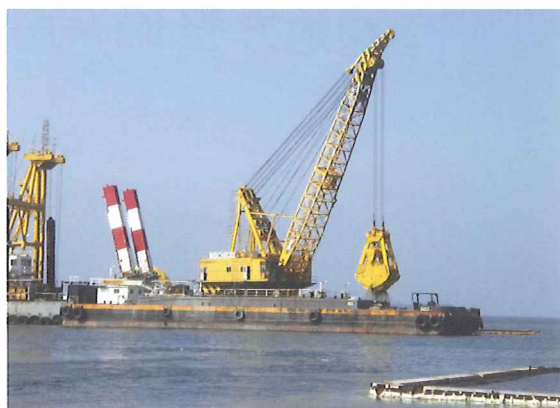
▲松山港の しゅんせつ 浚渫作業の様子
