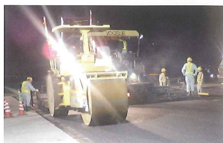
▲松山空港の舗装改良の様子
