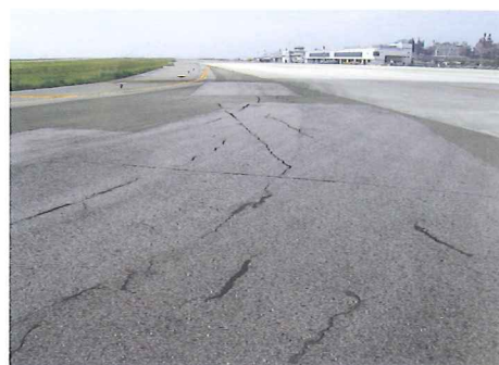
▲経年によるクラック（ひび割れ）
