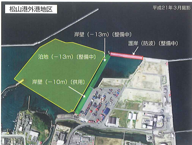
▲平成21年度松山港外港地区の整備状況
