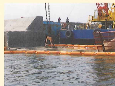
起重機船にバケットを取付け中詰材を撤去。
