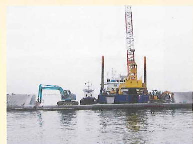
2台のコンクリートブレイカー（左右）で上部コンクリートを撤去。起重機船（中央右）でコンクリートブレイカーを運搬。
