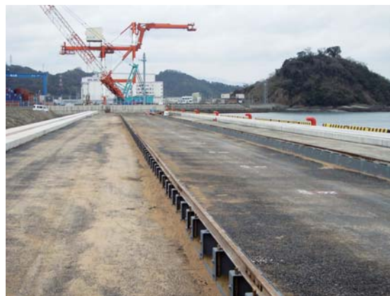
岸壁（水深13メートル）のエプロン*舗装
