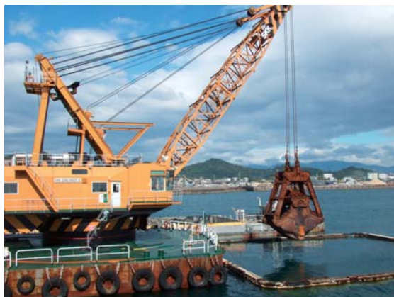
泊地（水深13メートル）の浚渫
