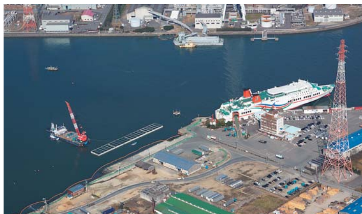
岸壁（水深7.5メートル）のケーソン据付
