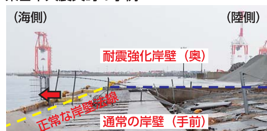
耐震強化岸壁（仙台塩釜港 仙台港区）の効果
