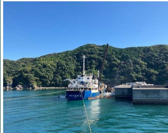
①東防波堤 基礎工(R6.12撮影)
