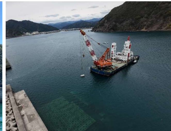
②東防波堤 被覆・根固工(R7.3撮影)
