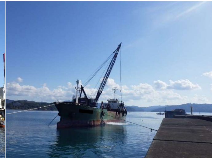
②防波堤(Ⅰ) 基礎工(R6.12撮影)
