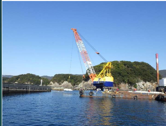
①防波堤(Ⅰ) 被覆・根固工(R7.2撮影)
