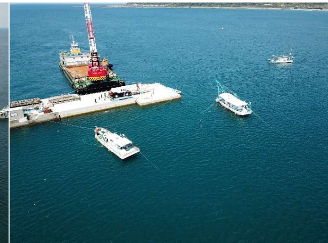
②防波堤(Ⅱ) 基礎工(R6.4撮影)
