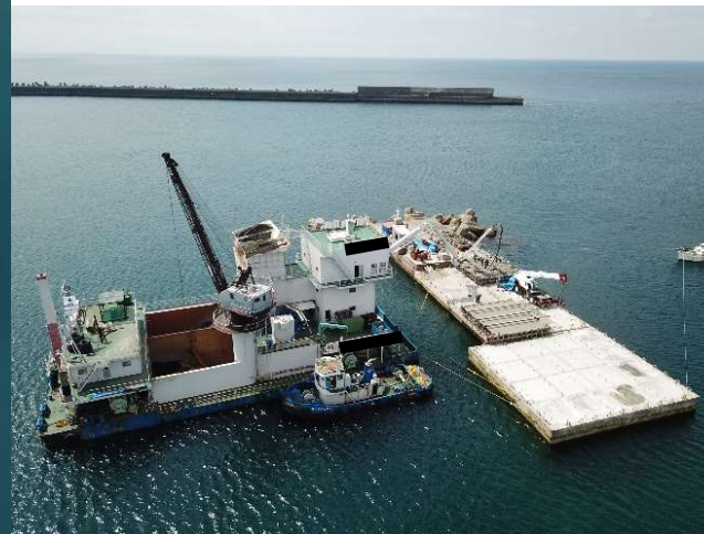
①防波堤(Ⅱ) 上部工(R6.4撮影)
