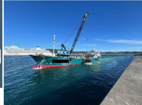
①防波堤(東第一)(直轄施工) 腹付工(R7.10撮影)
