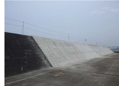
③防波堤(南)(直轄施工) 上部工(R7.7撮影)
