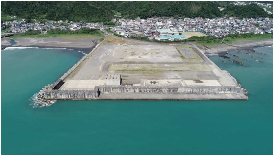
作業ヤード全景
