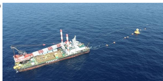
【GPS波浪計設置状況】
