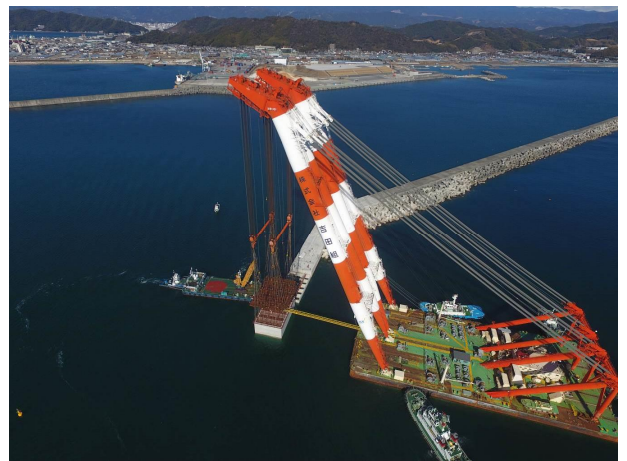
ケーソン据付作業：午前11時～
