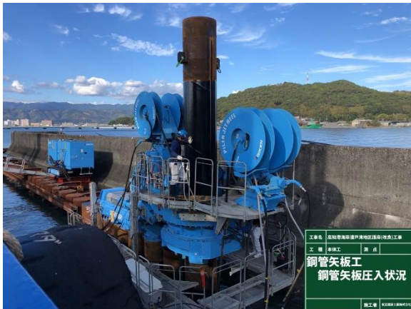
鋼管矢板打設作業
