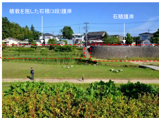
植栽を施した石積(3段)護岸(左)と石積護岸(右)の例 天端高は同じであるが植栽によって印象が変わる (神奈川県横浜市)
