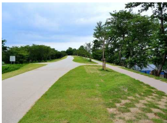
堤防の天端部に植栽や配置を配慮した例 (三重県伊勢市)
