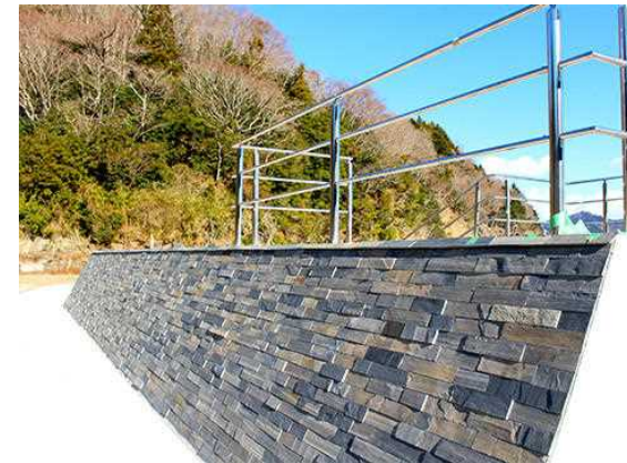
堤防に石張りを施した例(宮城県石巻市) 出典:「新しい東北」官民連携推進協議会
