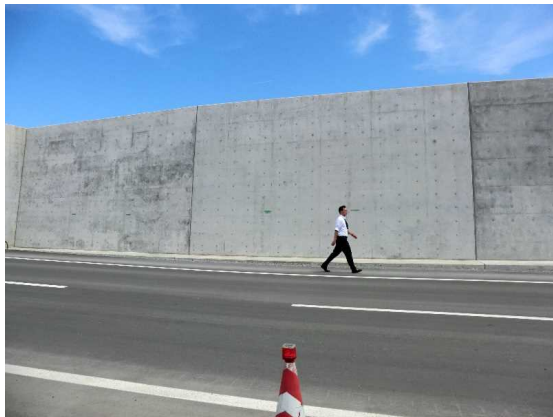
一般的な壁式防潮堤の例(岩手県大船渡市) 単調な印象になりやすい
