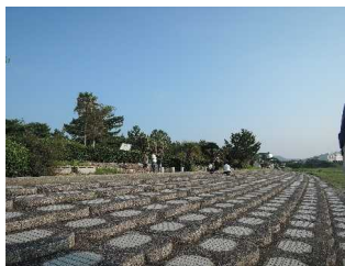
参考写真-1 既設傾斜護岸の階段ブロック
