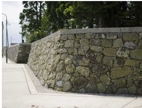
堤防に空積みを設置した例(宮崎県美々津) 堤防としての認識が軽減されやすい
