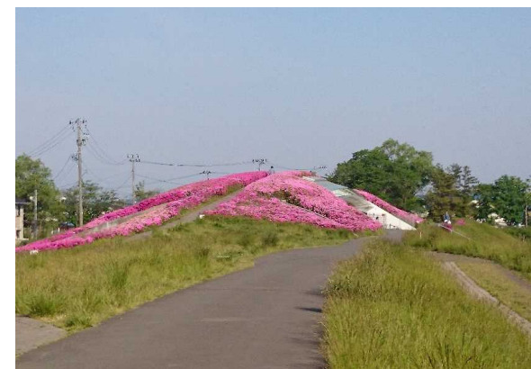
計画堤防を越える盛土と盛土内施設 北上川運河交流館(宮城県石巻市)
