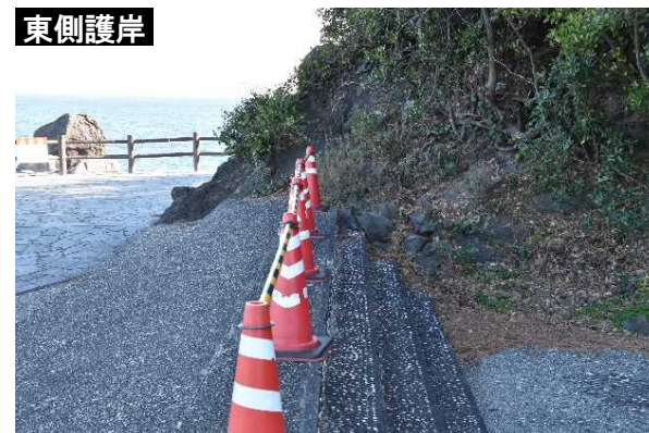
東側護岸 護岸の端部 （龍馬像下の接続部分）
