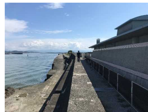
桂浜信号所裏の通路
