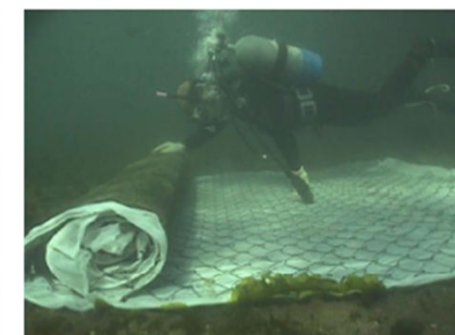
② ダイバーによるマットの設置
