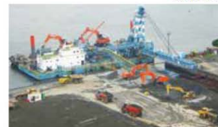
落下混合工法
