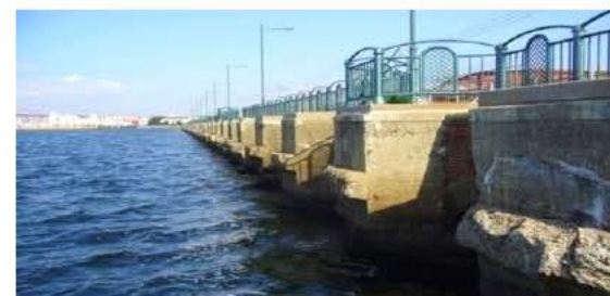
・生物共生型港湾構造物は、天端水深-1mのアイロン型(H22. 1末完成)。
