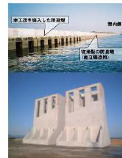
三島川之江港の防波堤延伸時に設置されたエコシステム型ケーソン
