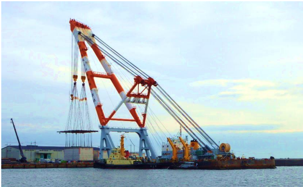
(沖洲)ケーソン吊上げ作業状況(イメージ)
